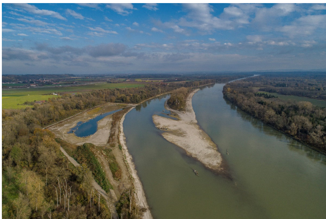
Abbildung 9 Strukturierungen in der Stauwurzel (nach Fertigstellung © Lorenz)
