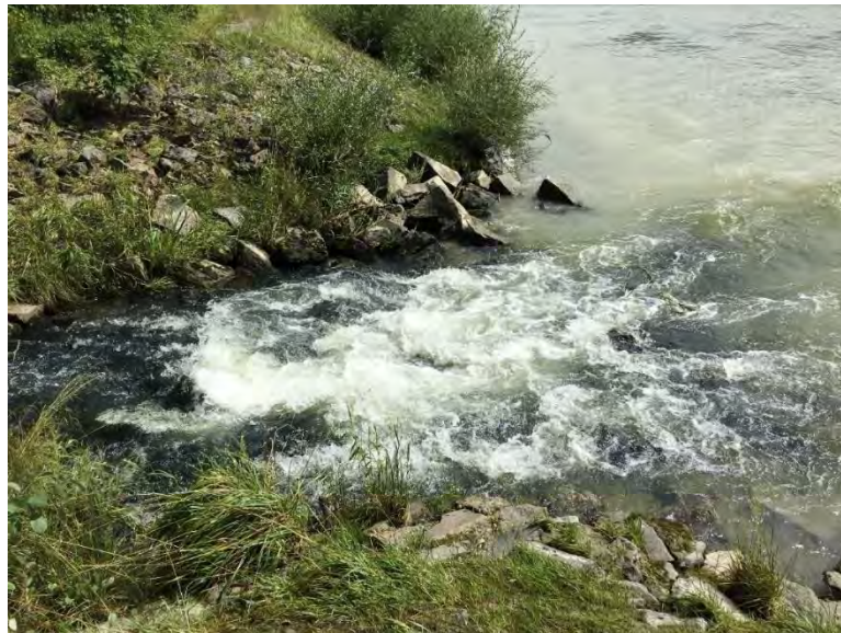
Abbildung 28: Mündungsrampe des Malchinger Baches in den Inn.
