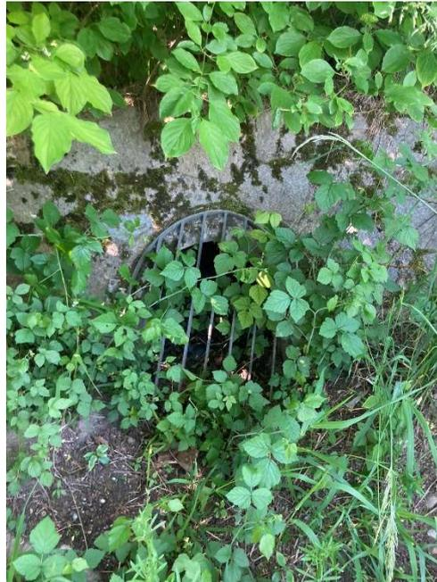
Abbildung 8: Einleitungsstelle für das Oberflächenwasser der unteren Inntalstraße in den Zeller Graben
