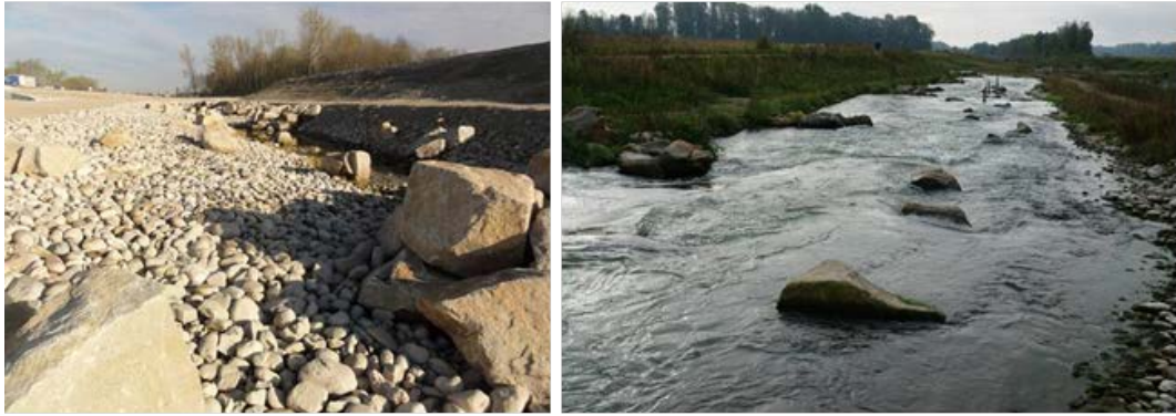
Abbildung 5: Asymmetrisches Raugerinne mit Rauigkeitselemente ohne Hochwasserbelastung mit und ohne Abfluss (Verbindungsbauwerk Flutmulde Machland / Donau)
