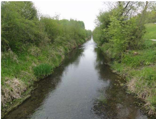
Abbildung 20: Sickergraben/Malchinger Bach im Bereich von Inn-km 37,65
