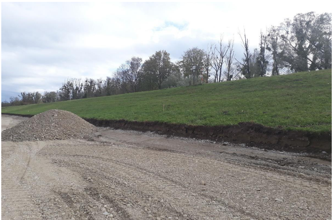
Baufeld Zustand am 25.10.2018
