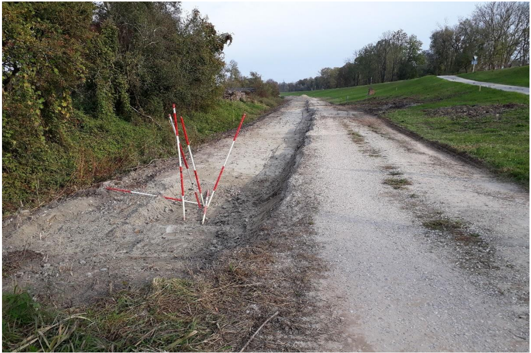
Bodenabtrag, Zustand am 15.10.2019:
