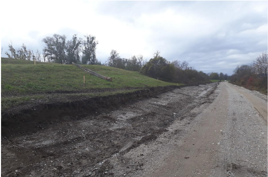
Baufeld Zustand am 25.10.2018
