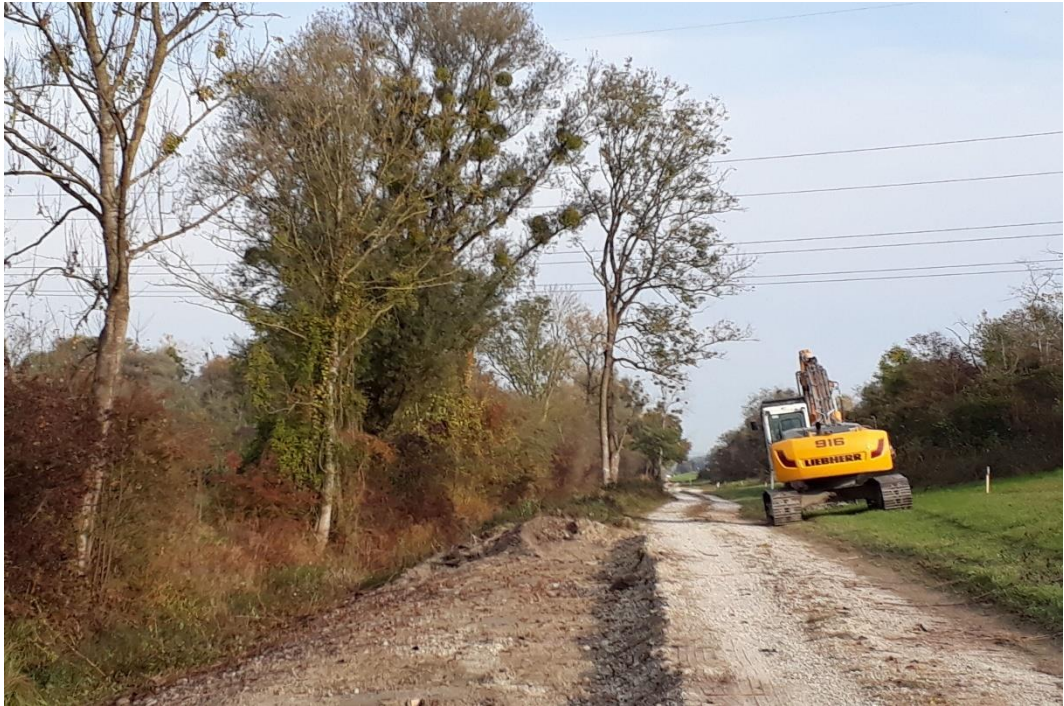
Bodenabtrag, Zustand am 15.10.2019:
