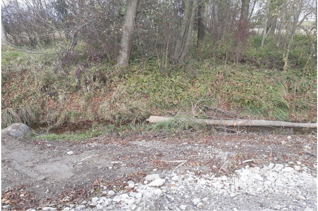
Baufeld Zustand am 25.10.2018
