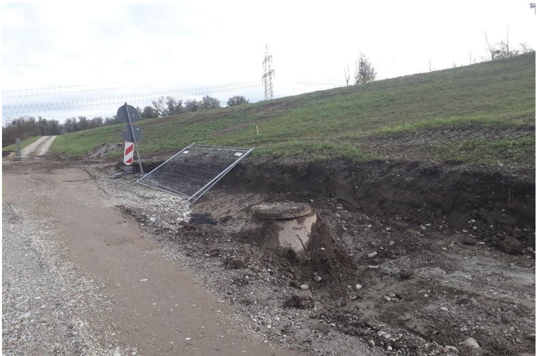
Baufeld Zustand am 25.10.2018
