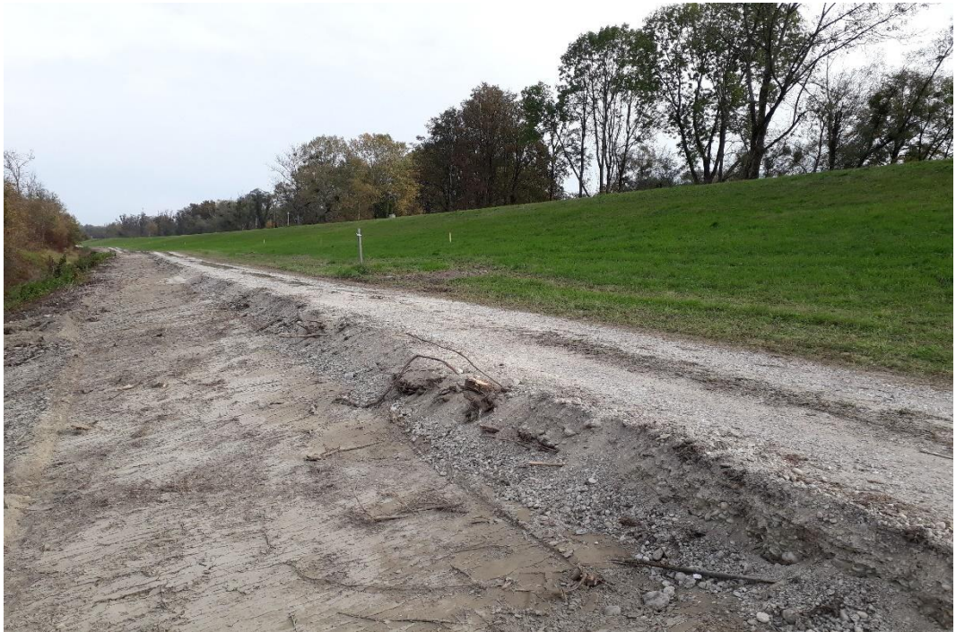
Bodenabtrag, Zustand am 15.10.2019:
