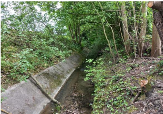
naturfernes Gewässerbett des westl. Ehebaches
