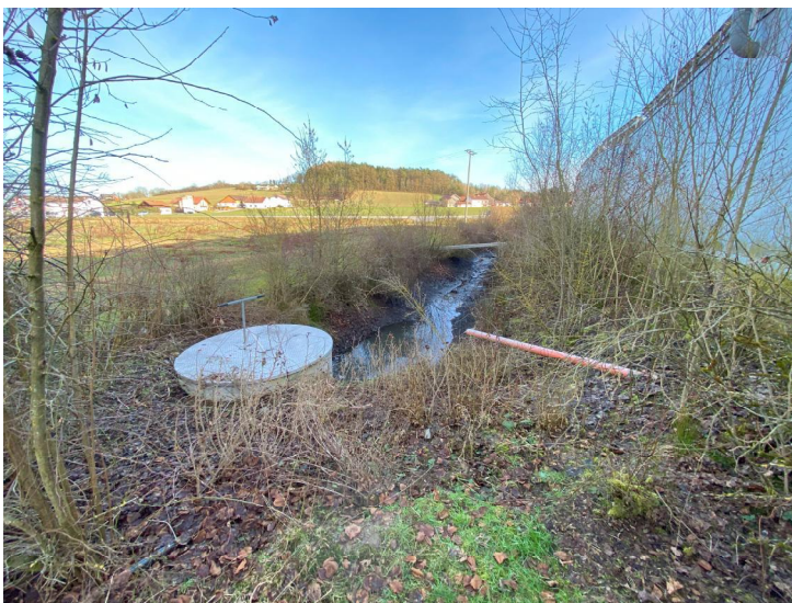
ABBILDUNG 4: BESTEHENDER REGENRÜCKHALTETEICH UTTIG 2
