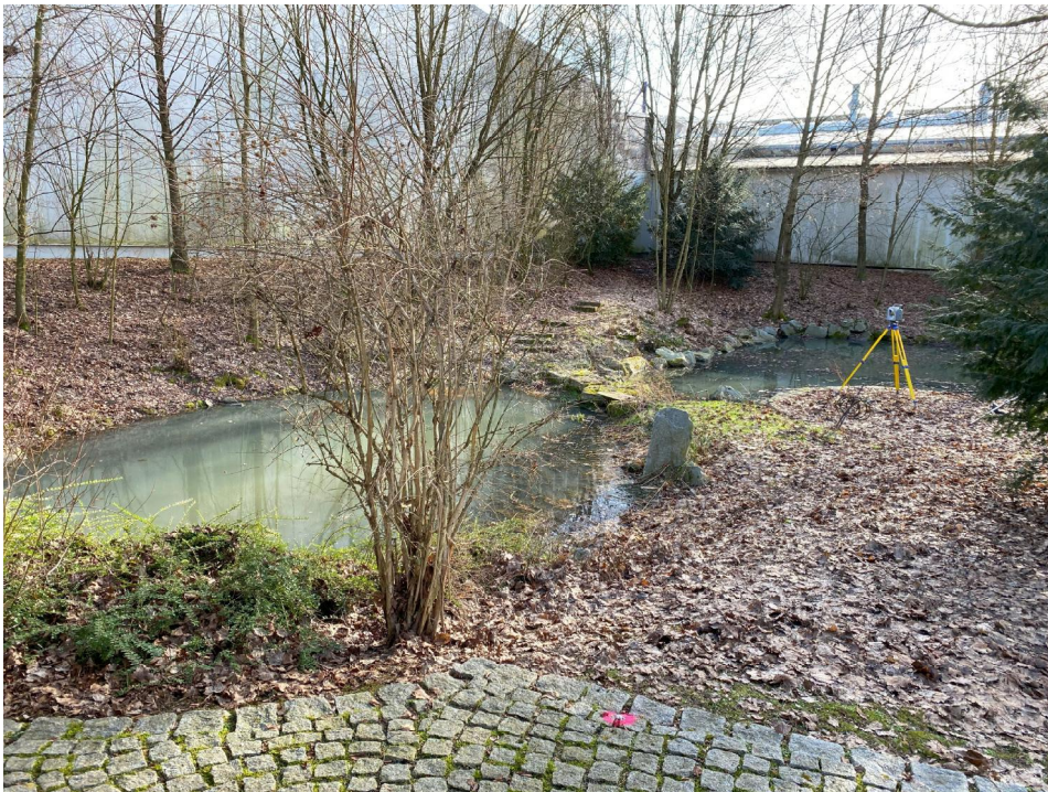
ABBILDUNG 2: BESTEHENDER REGENRÜCKHALTETEICH UTTIG 1
