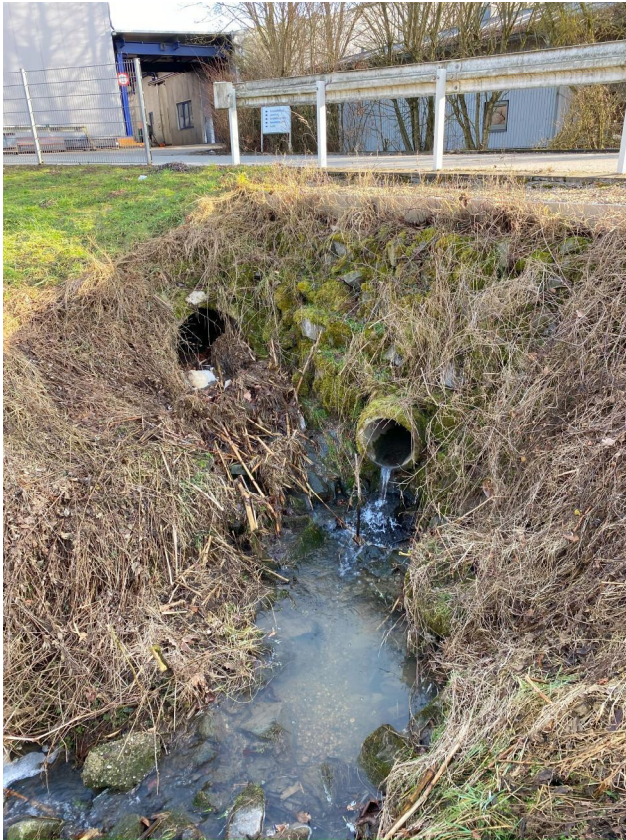
ABBILDUNG 3: BESTEHENDE EINLEITSTELLE UTTIG 1
