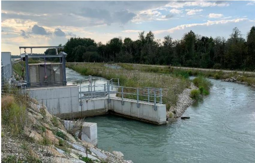
Abbildung 16: Ausstiegsbauwerk am Beispiel der OWH am KW Ering-Frauenstein. Wanderkorridor (Einlaufgerinne) verläuft im Hintergrund
