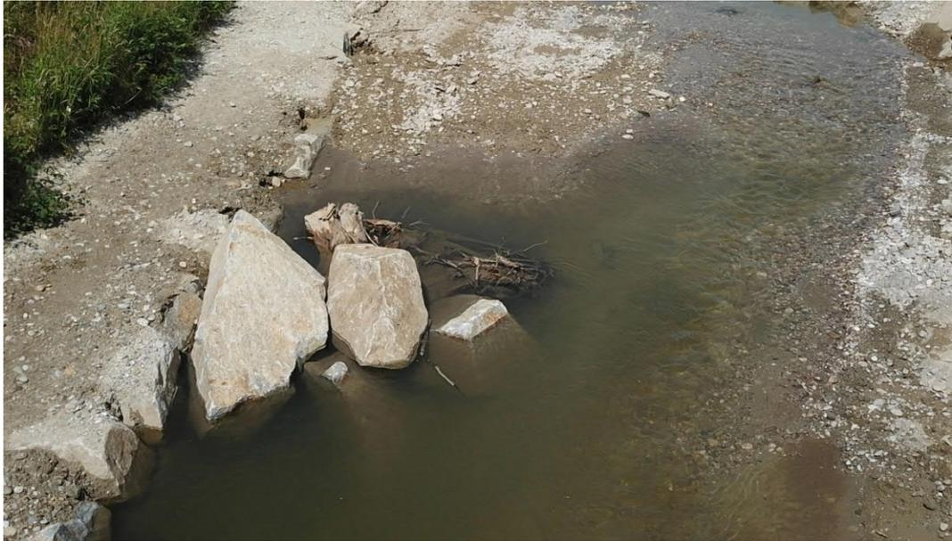
Abbildung 15: Bühnenstruktur mit eingebautem Wurzelstock
