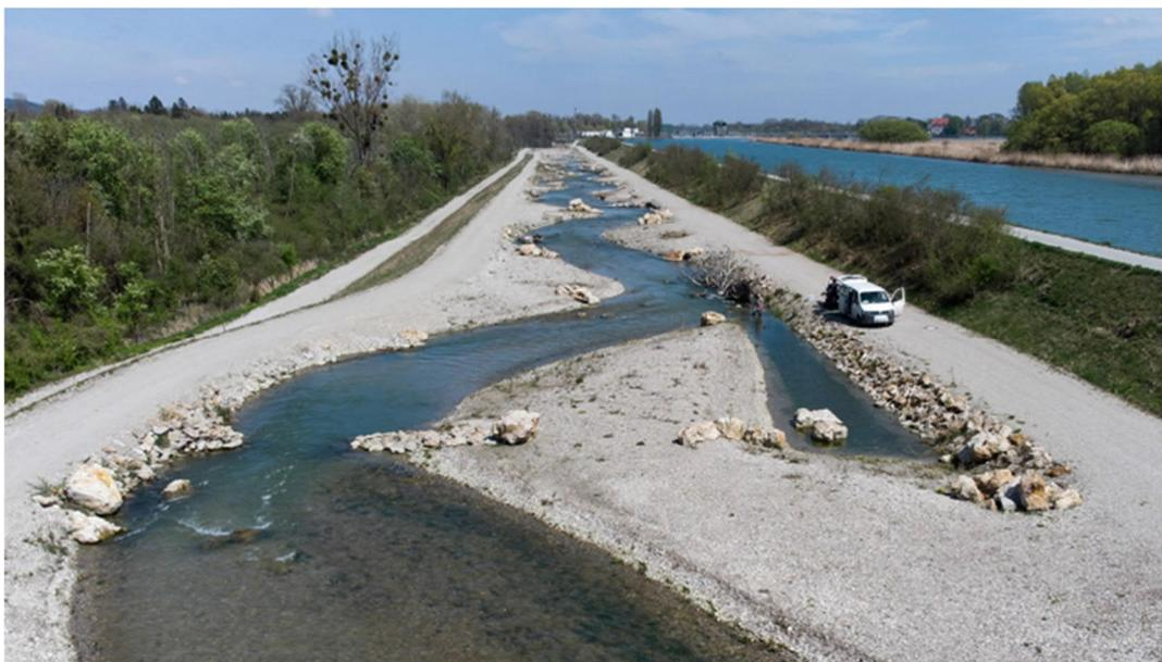
Abbildung 7: Rampengerinne des Umgehungsgewässers KW Ering-Frauenstein bei rund 2 m³/s Abfluss mit Blick flussab Richtung Kraftwerk Ering-Frauenstein.
