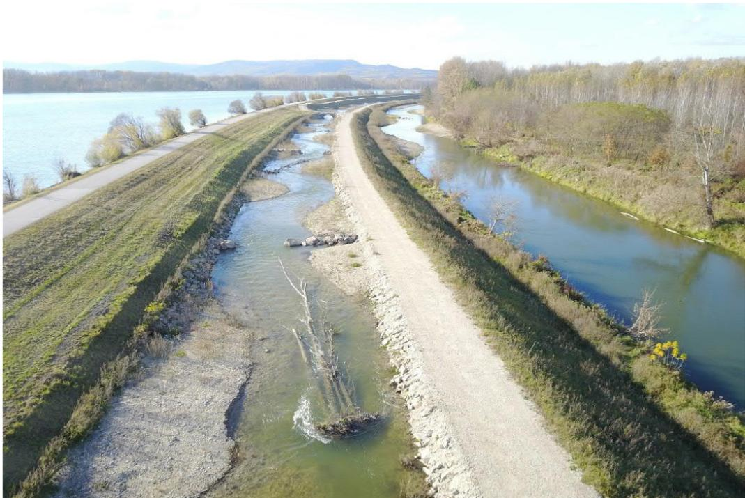
Abbildung 12: Strukturierungsbeispiel Rampengerinne OWH-Donau KW Altenwörth mittels Buhnen und Totholzpakten
