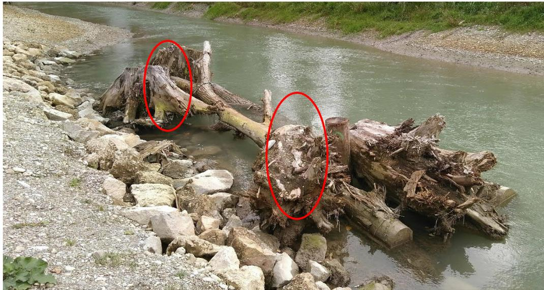
Abbildung 18: Totholzpaket – Befestigung Stahlseil an eingeschlagenen Holzpiloten
