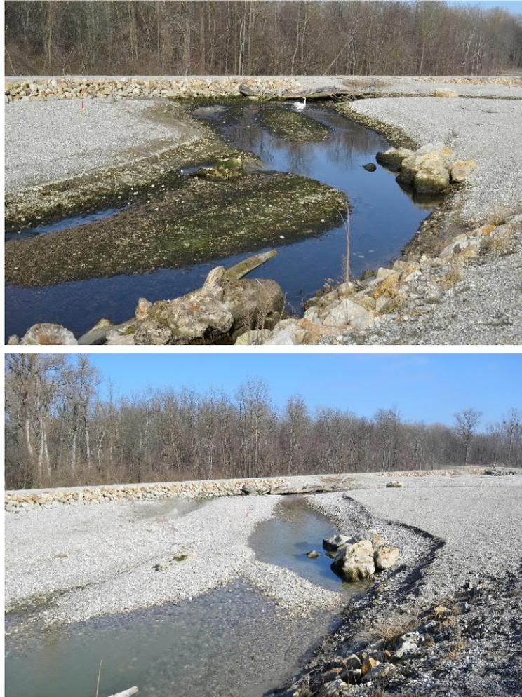
Abbildung 23:UMG KW Ering-Frauenstein – Oben: vor Spüldotation u. Unten: nach Spüldotation 2021 (Abfluss wegen Erhebungen stark reduziert)
