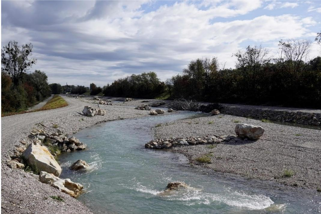
Abbildung 11: Strukturierungsbeispiel Rampengerinne Umgebungsgewässer KW Ering-Frauenstein mittels Buhnen, Störsteinen und Totholz
