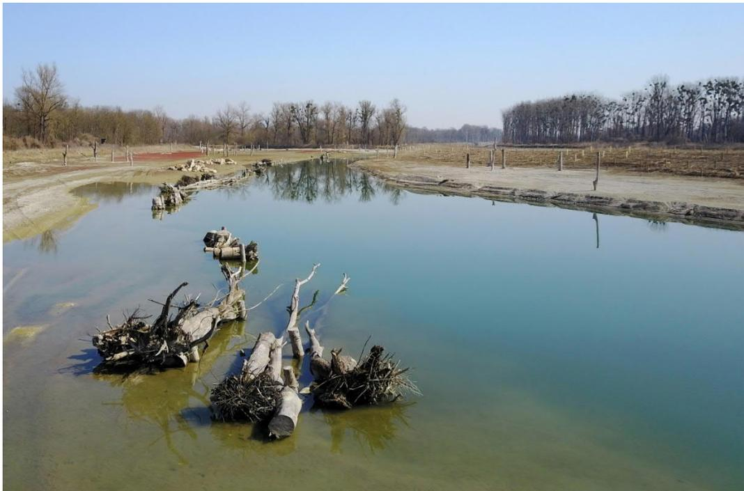
Abbildung 28: Vergleichbare Stillgewässerstruktur im Unterwasser des Kraftwerks Ering-Frauenstein mit eingebauten Totholzstrukturen
