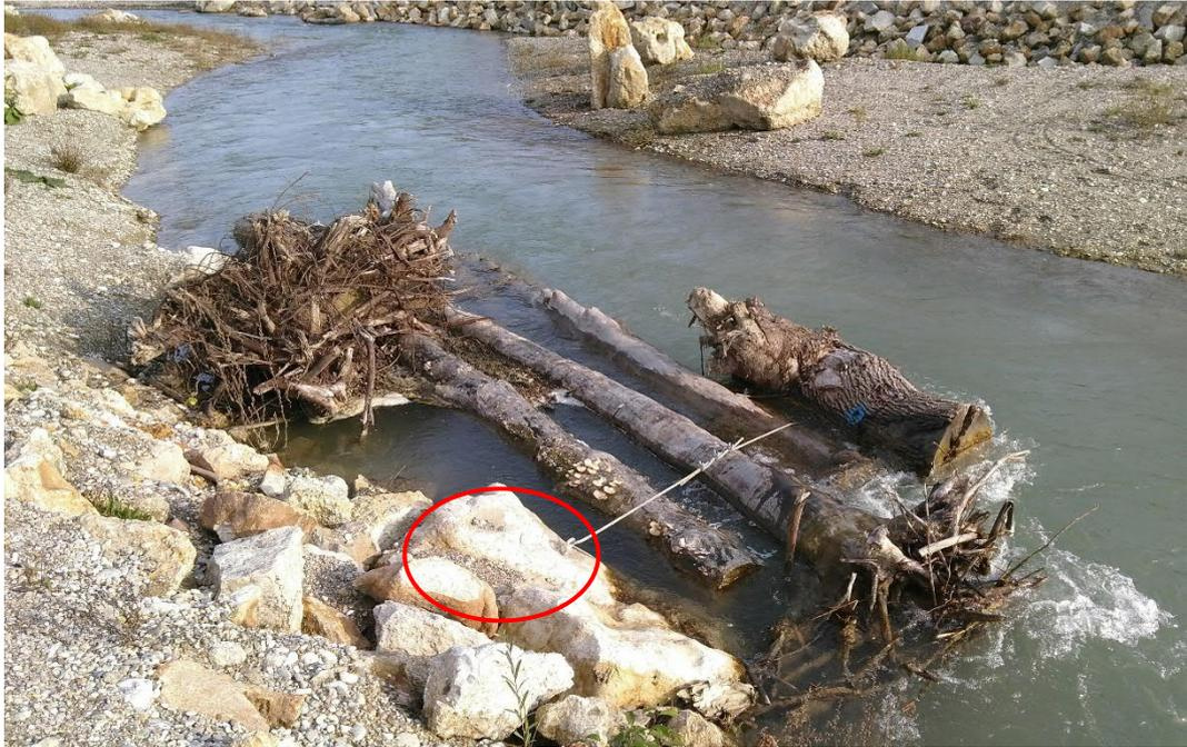
Abbildung 13: Totholzpaket Umgehungsgewässer KW Ering-Frauenstein - Befestigung Stahlseil an im „Findling“ eingesetzten Schlaganker
